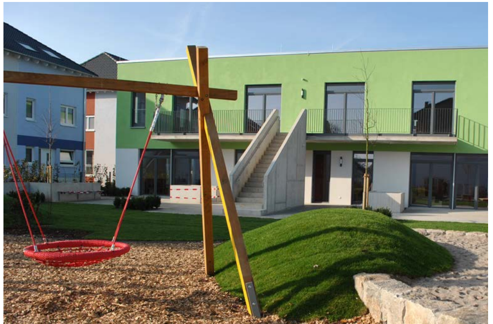
Gebäudeansicht aus Sicht der Freianlagen
