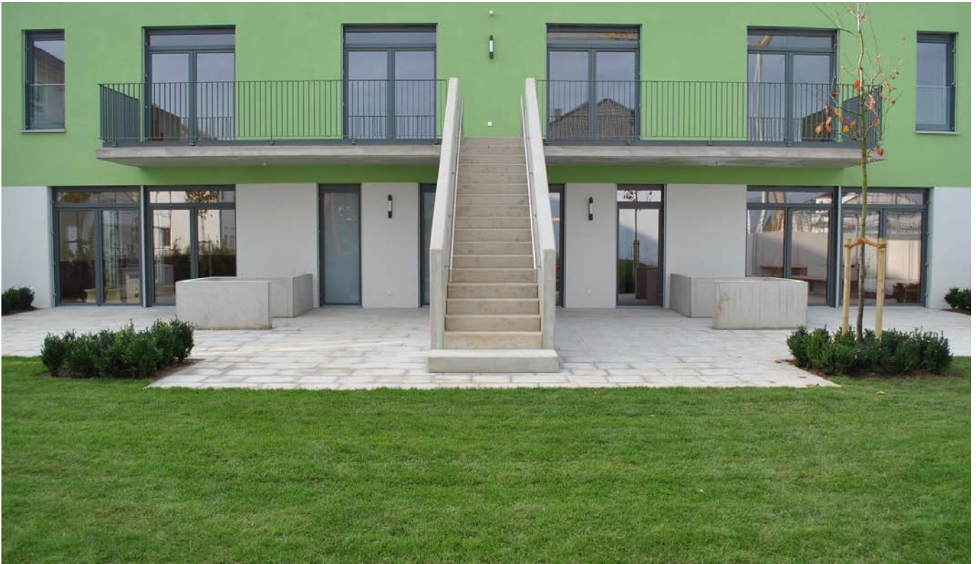
Verbindungsstreppe vom Freiraum in das erste Obergeschoss
